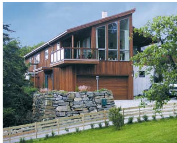
Moderne boliger er svært tette.
